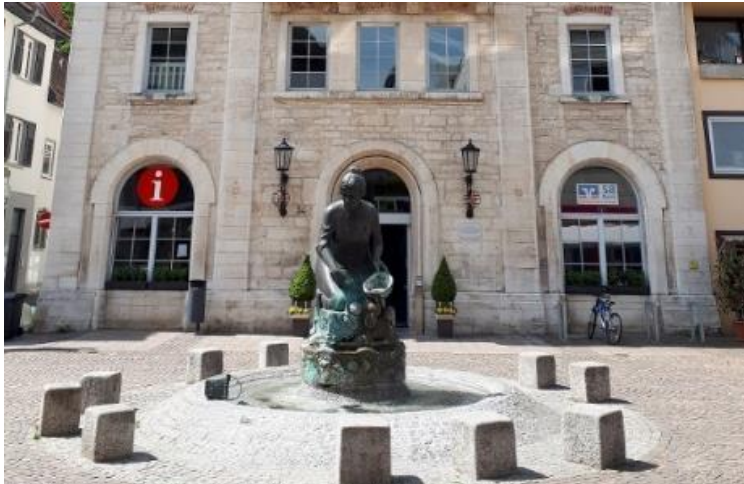
Abbildung 31: Knöpfleswäscherin-Brunnen als Barrierewirkung auf der Hauptstraße (Quelle: Stadt Heidenheim, 2019)
