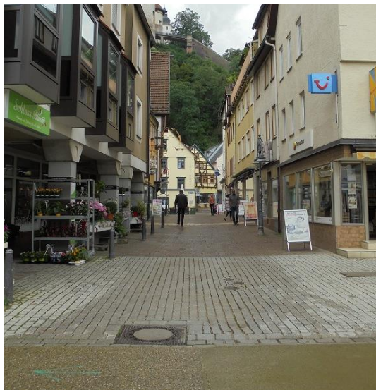
Abbildung 36: Wechselnde Straßenbeläge mit Barrierewirkung (Quelle: WHS, August 2019)
