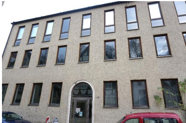
Abbildung 21: Leerstehendes Gebäude mit substanziellen Mängeln, Elmar-Doch-Haus (Anbau, Stand April 2021 bereits abgebrochen) (Quelle: WHS, November 2020)
