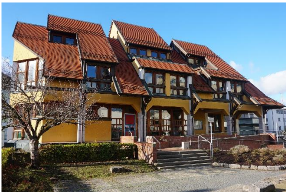
Abbildung 24: Schlechter Gebäudezustand, Meeboldhaus von außen (Quelle: WHS, 2020)
