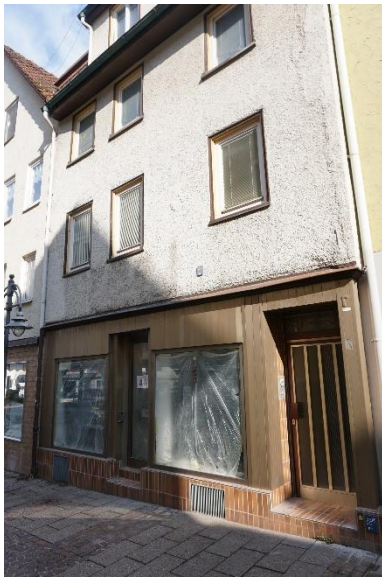
Abbildung 20: Leerstehendes Gebäude mit substanziellen Mängeln, Pfluggasse 7 (Quelle: WHS, November 2020)
