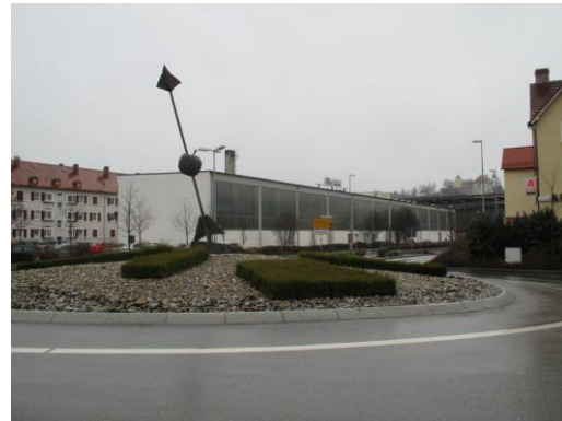
Abbildung 17: Fabrikgebäude Stowe Woodward (Quelle: WHS, 2016)
