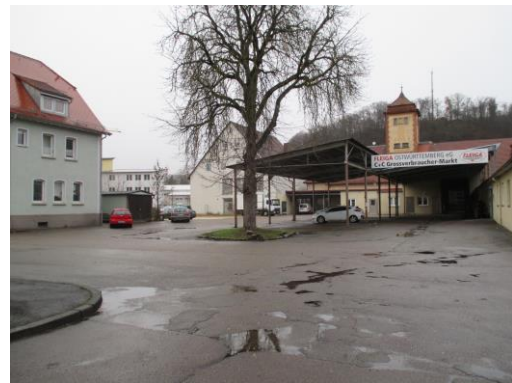
Abbildung 30: Firmengelände Fleiga Ostwürttemberg eG (ehem. Schlachthof) (Quelle: WHS, 2016)
