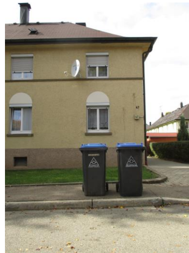
Abbildung 34: Modernisierungsbedürftiges Gebäude in der Leintalstraße (Quelle: WHS, 2015)
