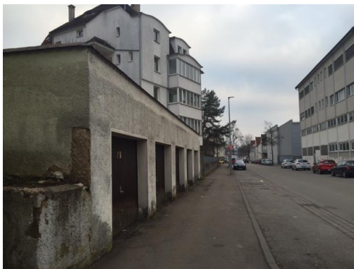
Abbildung 39: Garagenfront in der See- straße (Quelle: WHS, 2016)
