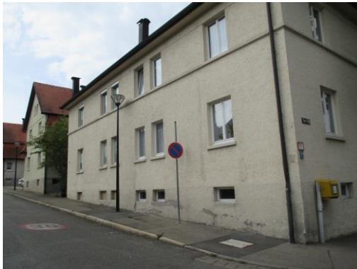
Abbildung 33: Modernisierungsbedürftiger Gebäudebestand in der Hermann-Poppe-Straße (Quelle: WHS, 2014)
